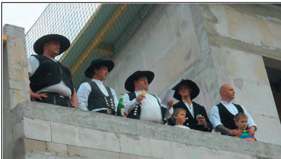
Richtfest: Rund 3 Millionen Euro investiert unsere Gemeinde für den Bau eines neuen Feuerwehrgerätehauses mit integrierter Rettungswache. Im Mai wurde Richtfest gefeiert.
